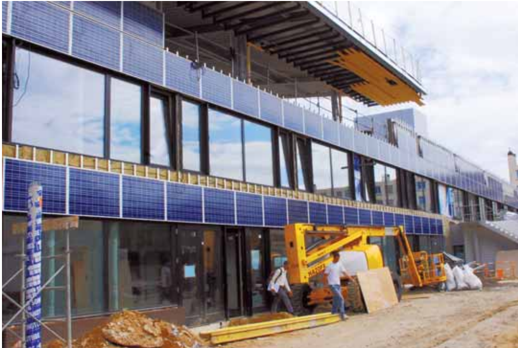
Construction de l'école « zéro énergie » Jean-Louis Marquéze à Limeil-Brevannes (94).
