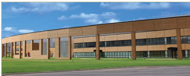
Vue de la façade en bois de l'entreprise SAMADA, filiale logistique de Monoprix, située sur le parc d'activités de la Borne blanche (77)
