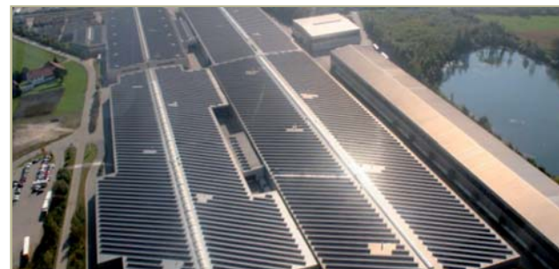
Solar Fabrik à Fribourg (ALL)
