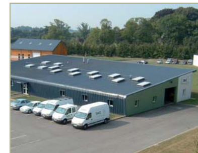
Société de maintenance et d'installation électrique. Parc Saint Romain de Colbosc (76)
