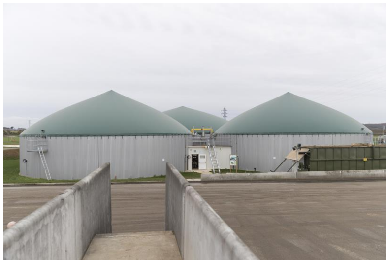
L'unité de méthanisation agricole Biogaz Meaux de Chauconin-Neufmontiers, 77. Crédit : AREC
