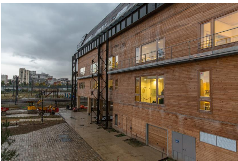
Réhabilitation de la Halle Pajol, Paris 18. Crédit : AREC
